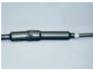
На сросток надвигаются полу-муфты, стыки обматываются мастикой и виниловой лентой
