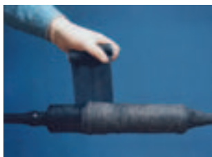
Для повышения жесткости муфты весь корпус муфты обматывается лентой Armorcast™ (включается в набор по требованию)
