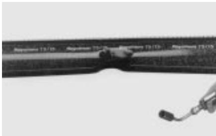
**19** Начинайте прогрев (усадку) с центра муфты с противоположной стороны от застежки. Непрерывно прогревайте по окружности, равномерно распределяя
