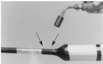
**13** Прогрейте кабели пламенем горелки на участке, указанном стрелками. Кабели с полизтиленовой оболочкой следует прогревать 10 секунд, а кабели со свинцовой оболочкой надо нагреть до 60°C (чтобы было горячо дотронуться).
