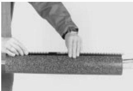
**16** Надвиньте гибкие застежки на направляющие пластины (рельсы) и продвиньте их до стыковки над стопорным хомутом. Отцентрируйте муфту на сростке так, чтобы края ее совпадали с синими линиями на алюминиевой фольге.
