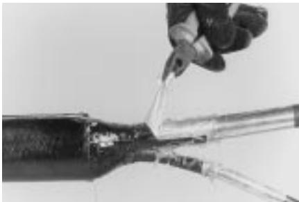
7 Плоскогубцами удалите с кабеля алюминиевую пленку перекрывающего клапана. При необходимости немножко прогрейте.
