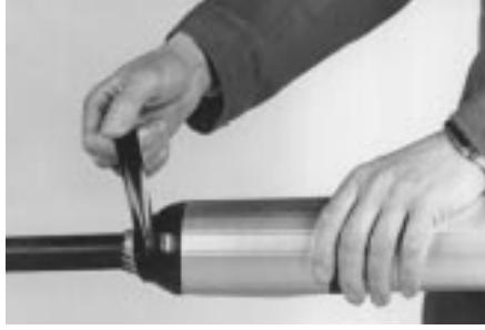
7 Обмотайте липкой лентой зубчатые края прокладки-каркаса, начиная с цилиндрической части каркаса (10 мм) и далее по конусу к оболочке кабеля с 50% перекрытием. (Используйте термостойкую ленту).
