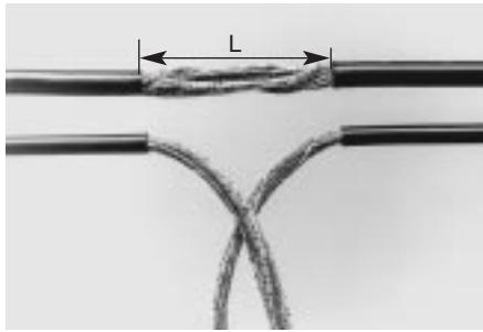
1 Удалите оболочки кабелей на длине L, следуя местным правилам разделки и сращивания и пользуясь обычным инструментом. С одного конца к муфте можно подвести не более 3-х кабелей.
