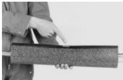
**14** Оберните термоусаживаемую манжету вокруг сростка. Установите стопорный хомут (если таковой имеется) поверх направляющих пластин (рельсов) и сожмите его в центре муфты.
