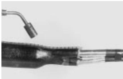
**22** После этого прогрейте зажим, рельс и область замка на концах кабеля. Примечание: При температуре воздуха ниже 0°C, прогревать следует больше, чтобы убедиться в вытекании клея.
