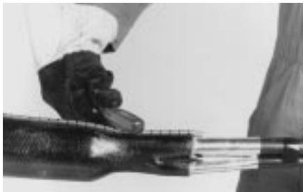
**21** Прижмите застежку тупым инструментом, чтобы она повторяла форму конуса муфты. Примечание для разветвительных соединений: Сожмите ответвляемые кабели пластмассовым пояском из комплекта ВОКТ. Повторите операции 19 и 20, начиная с центра и перемещая пламя к другому концу муфты. Подождите 15 минут, чтобы муфта остыла, перед тем как дальше работать с кабелем.
