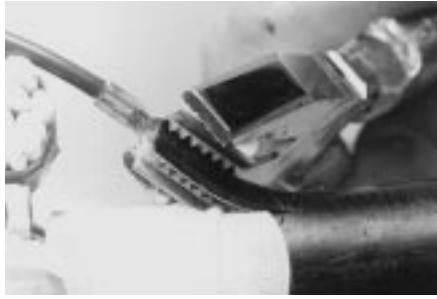
4 Используя плоскогубцы, подключите зажимы провода для восстановления экрана к металлическим оболочкам (закранам) кабелей.
