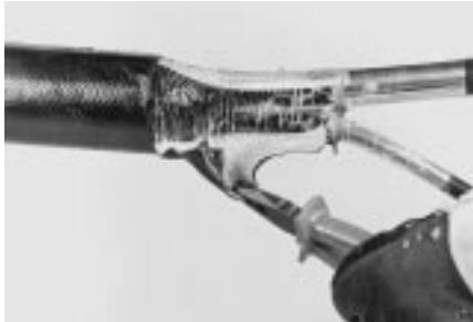
5 Удалите конец муфты плоскогубцами, осторожно стягивая его с кабелем. При необходимости дополнительно прогрейте.
