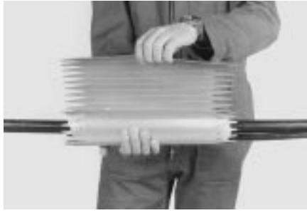
6 Перед установкой сверните прокладку-каркас, придав ей цилиндрическую форму. Плотно обмотайте место стростка прокладкой-каркасом и закрепите края липкой лентой.
