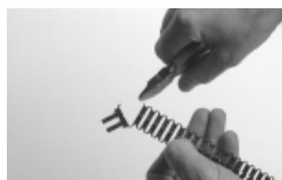
8 Обрежьте первую секцию зажимающей ленты, как показано на рисунке, но не срезайте её полностью. Частично отрезанная секция может быть использована как вспомогательное средство фиксации ленты при обёртывании её вокруг кабеля. (см. п. 9).
