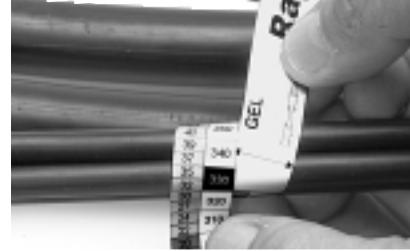
15 Определите общий наружный диаметр, измерив кабели как диаметр одиночного кабеля для определения требуемой длины гелевой и зажимающей ленты. Отрежьте обе ленты до необходимой длины, но не устанавливайте их на кабель.
