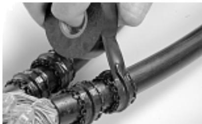
10 Удерживая зажимающую ленту на месте, закрепите её ПВХ лентой. **Обратите внимание:** возможна установка зажимающей ленты сразу на кабеле и затем перемещение её в правильное положение.
