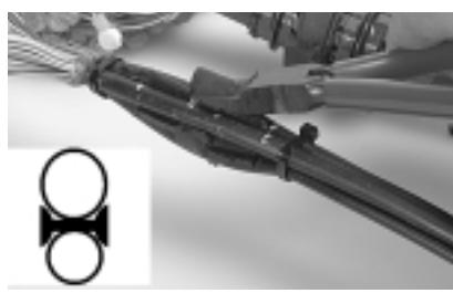
20 Установите пояски-стяжки вокруг кабелей между срезом оболочки и первой маркировкой. Вставьте две резиновые / гелевые накладки между кабелями. Резиновая секция накладки устанавливается в зоне A1 и A2. Гелевые секции устанавливаются в область B. Сожмите пучок кабелей вторым пояском-стяжкой. Удалите концы пояска-стяжки.
