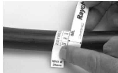
11 Определите длину гелевой ленты, оборачивая мерную ленту вокруг оболочки кабеля.
