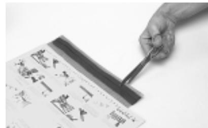
12 Обрежьте гелевую ленту до нужной длины. Используйте шаблон, напечатанный на краю монтажной инструкции или квадраты, напечатанные на съёмной бумаге гелевой ленты. Квадраты напечатаны по возрастанию с шагом 1 см.
